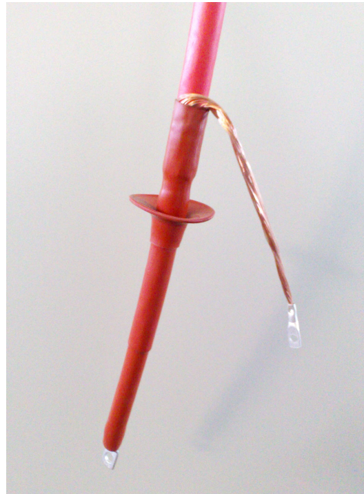
شکل (۲۵): شیلد بافته شده کابل آماده اتصال به شینه زمین تابلوی فشار متوسط
