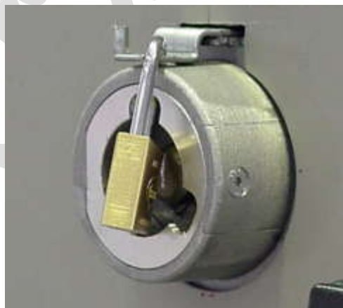
شکل (۳۶): قفل عملکرد سکسیونر یا کلید زمین
