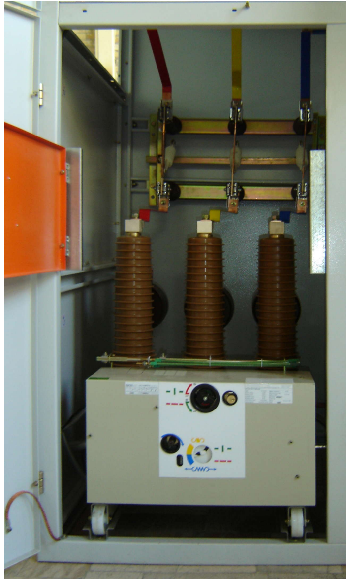
شکل (۴): نمای داخلی یک نمونه سلول کلید قدرت
